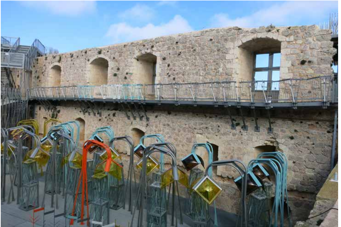
Pasarela entre torreones
