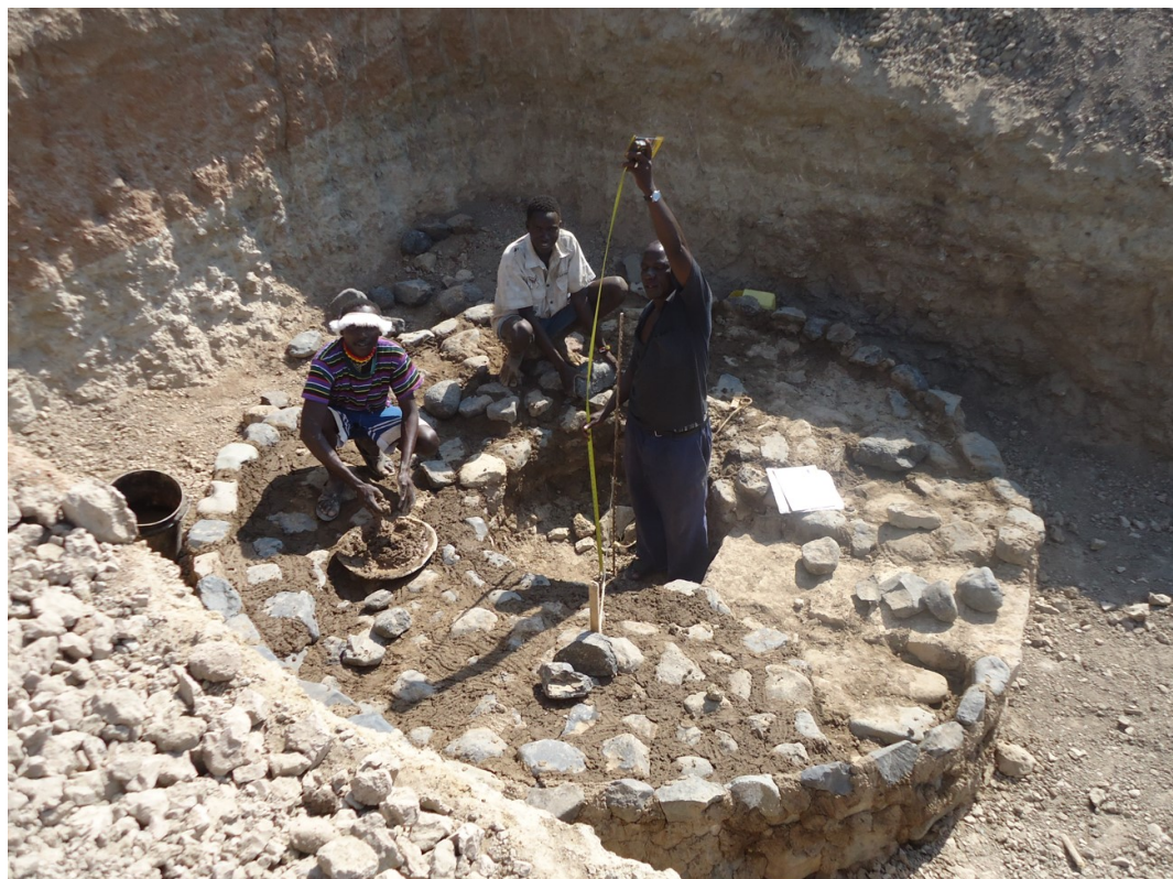
Construcción del primer horno de cal en la Misión de Nariokotome
