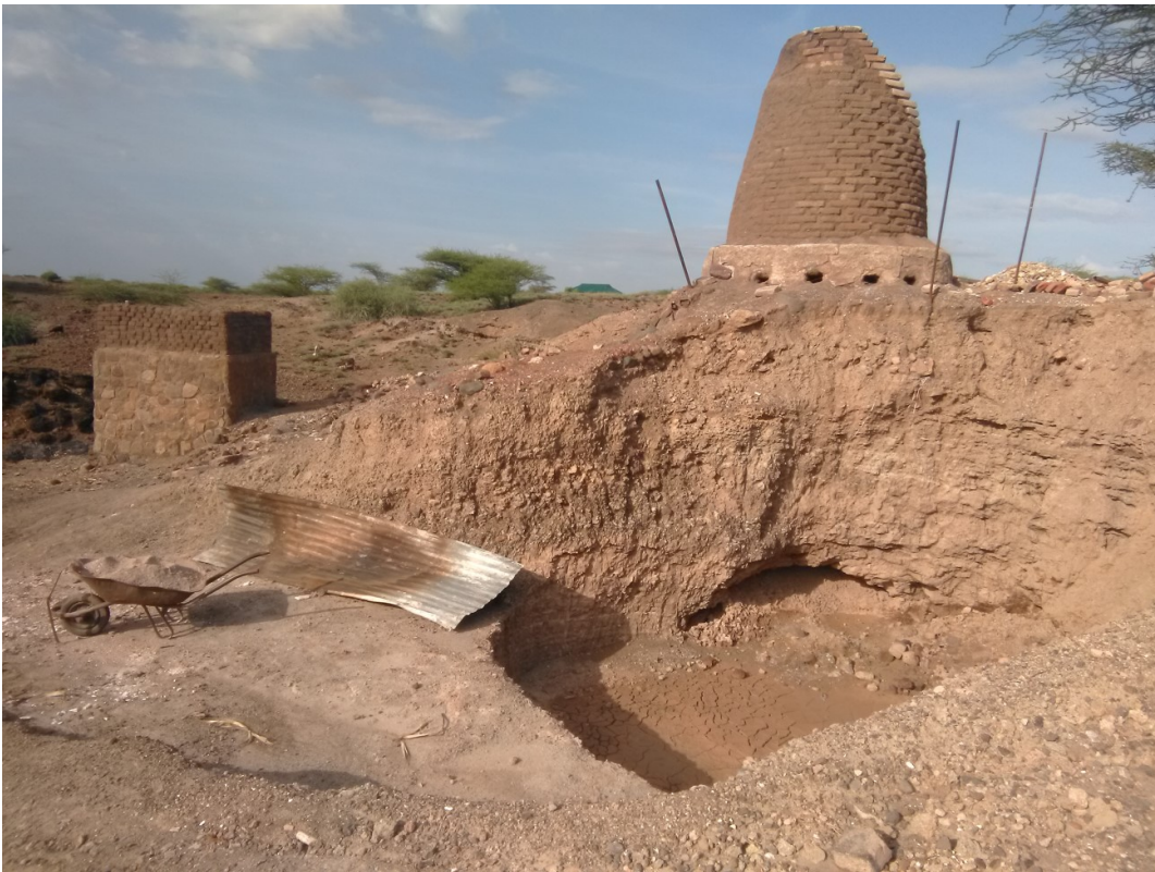
Construcción del segundo horno de cal en la Misión de Nariokotome
