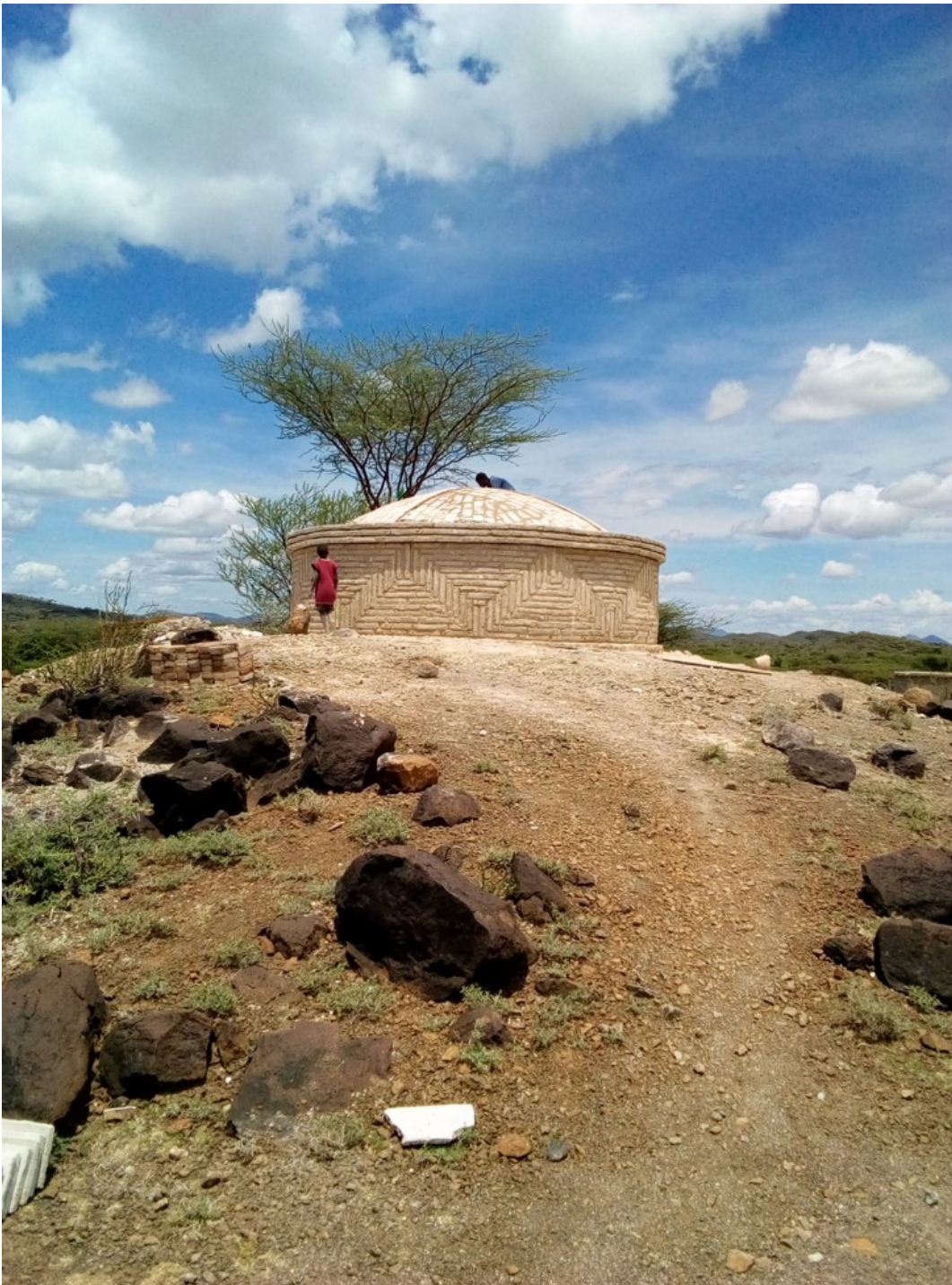
Depósito de agua en el poblado de Kopotia casi terminado.
