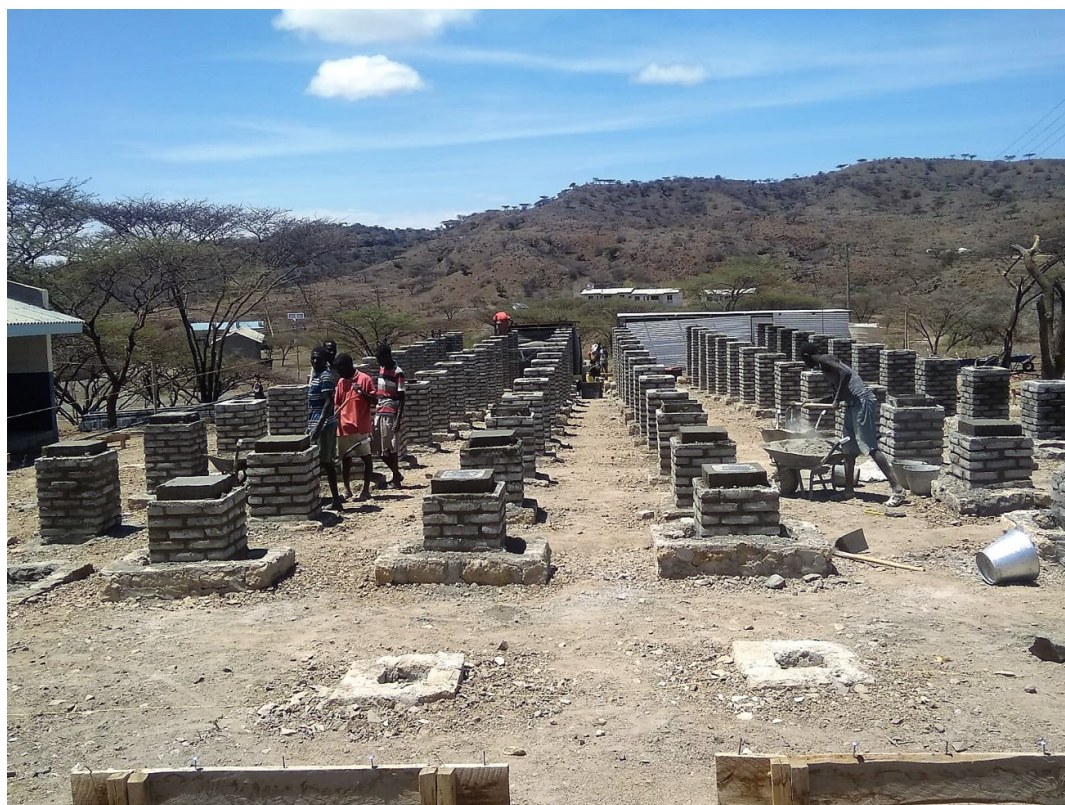
Cimientos del Quirófano oftalmológico de Lokitaung
