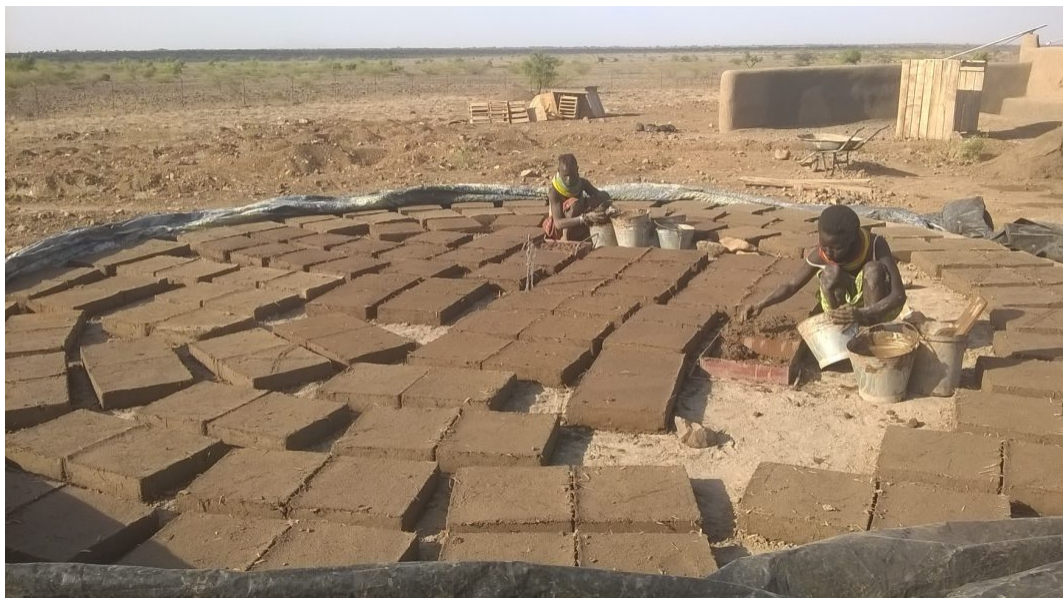
Fabricación de adobes para la construcción de la guardería de la Misión de Lobur
