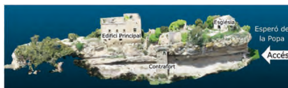
Figura 4. Visión general de la vertiente izquierda del conjunto del castillo de Castellcir o de la Popa. Página 4, figura 4 de la Nota técnica de la visita realizada al Castell de Castellcir (Moianès) para evaluar el riesgo geológico en la estabilidad del macizo y caída de bloques, ICGC.AP0052/20 (Ferran Parera Morales, Unidad de ingeniería geológica y geotecnia y Marc Janeras Casanova, Jefe de la unidad de ingeniería geológica y geotecnia, del Área de geotecnia y prevención de riesgos geológicos, del Instituto Cartogràfic y Geològic de Catalunya. Barcelona, 1 de Julio de 2020.
