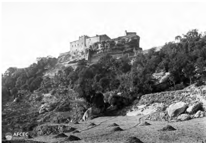
Figura 5. Fotografía de 1906 de la vertiente izquierda del castillo de Castellcir. Figura 16 de la página 13 de la Nota técnica de la visita realizada al Castell de Castellcir (Moianès) para evaluar el riesgo geológico en la estabilidad del macizo y caída de bloques, ICGC.AP0052/20. (Juli Vintó, 1906 CEC. Archivo fotográfico del Centro Excursionista de Cataluña).
