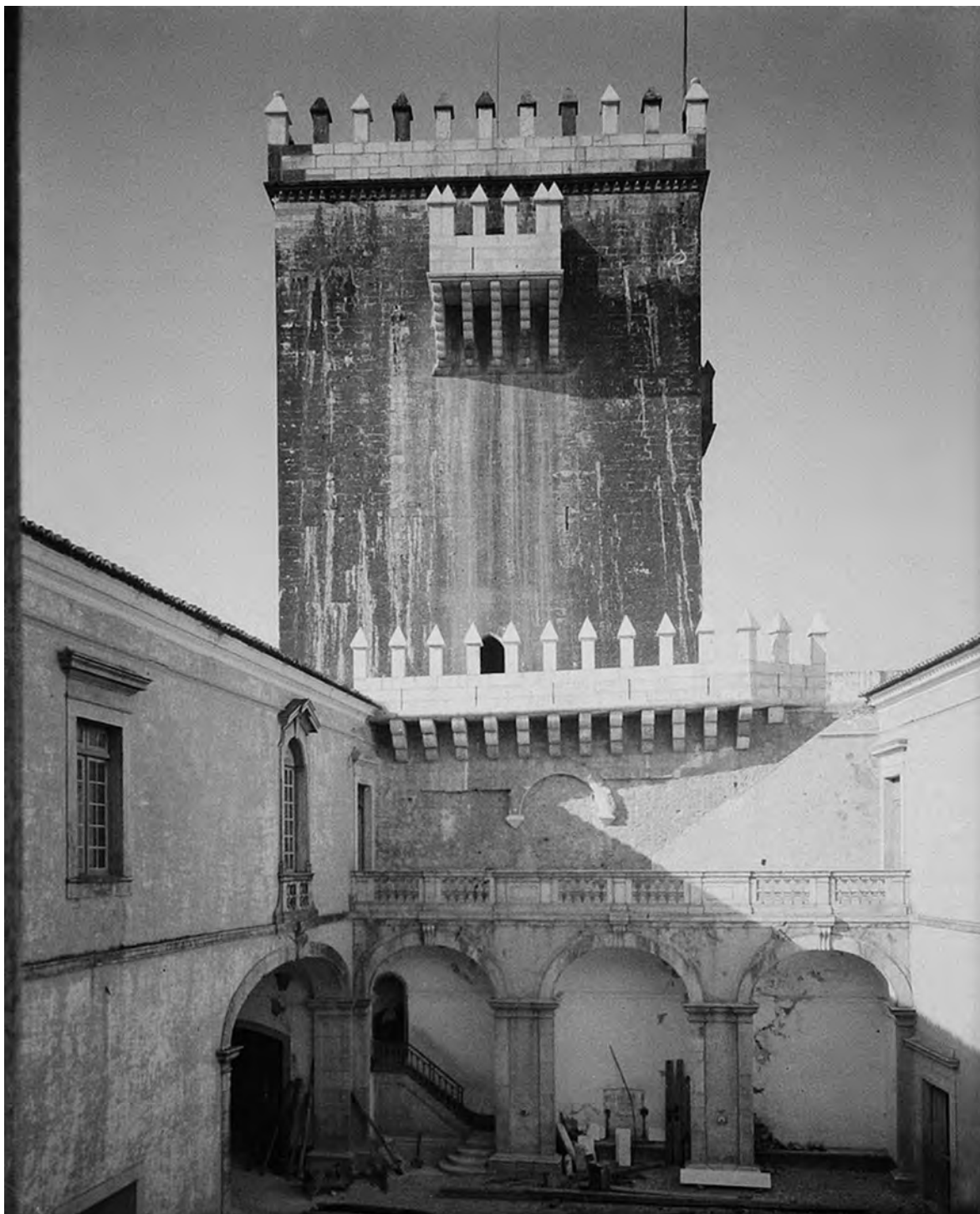
Figura 3. Pátio e Torre de Menagem do Castelo de Estremoz depois das obras (1941). Sistema de Informação para o Património Arquitectónico (SIPA.FOTO.00157227), Forte de Sacavém.
