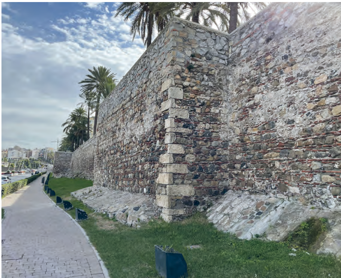
Lámina 1. Vista parcial de la muralla norte de Ceuta. En primer término, la torre del Mirador (TO 6)
