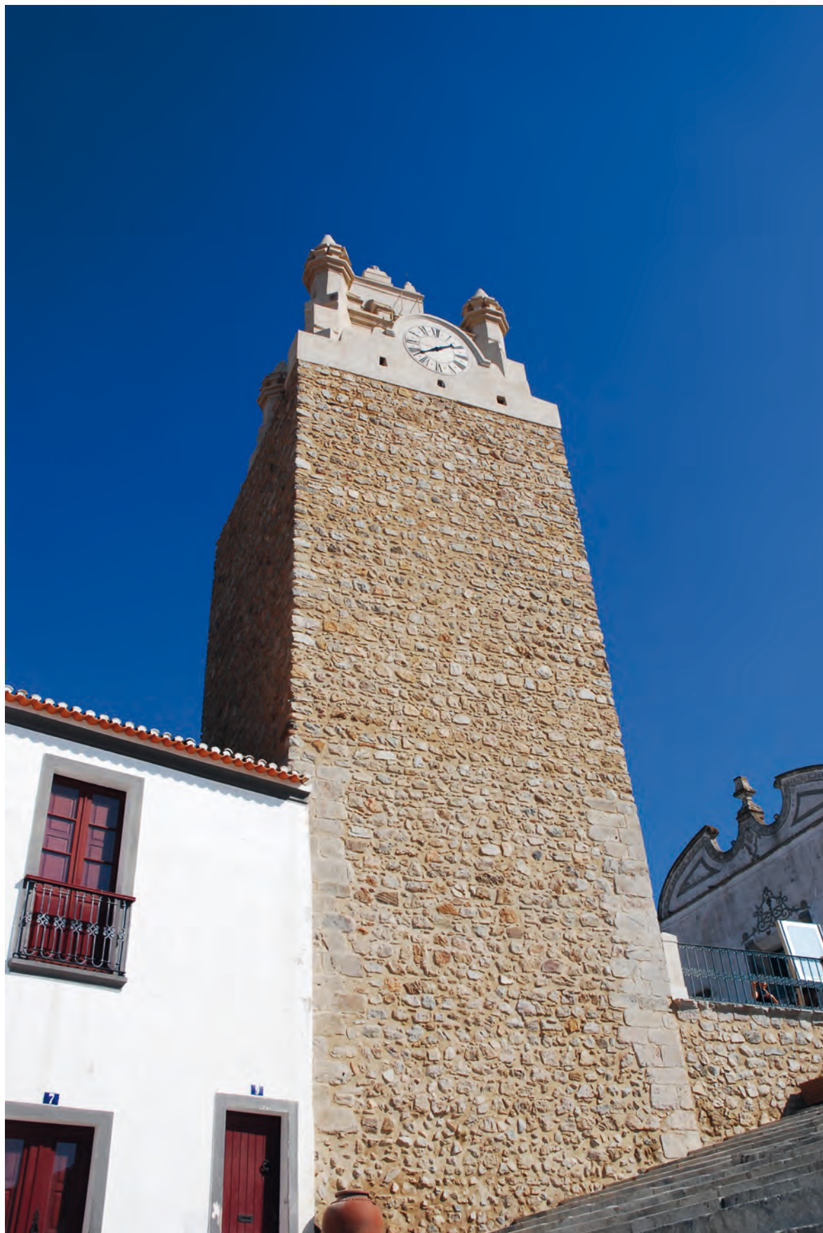
Figura 5. Torre del Reloj después de la rehabilitación (2018)
