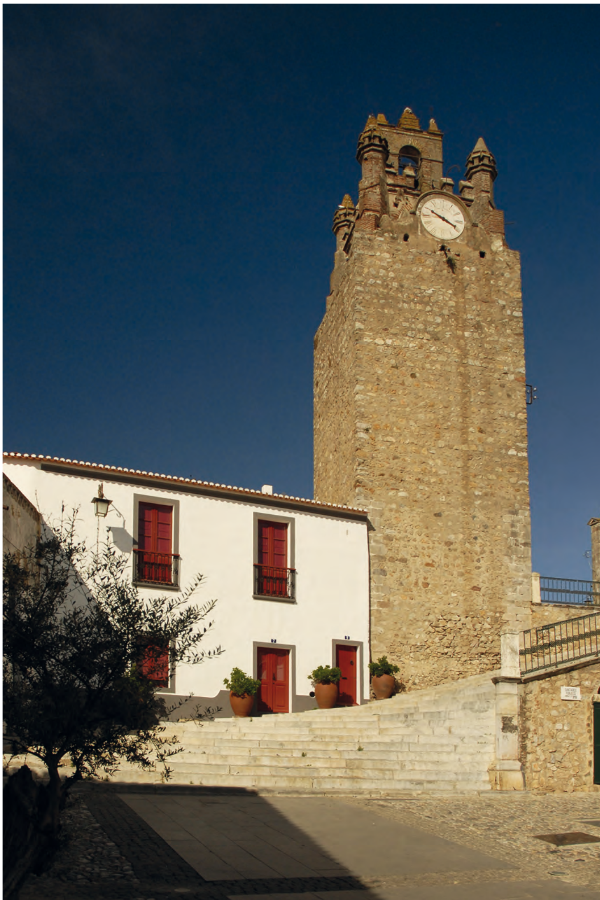
Figura 4. Torre del Reloj antes de la rehabilitación (2015)
