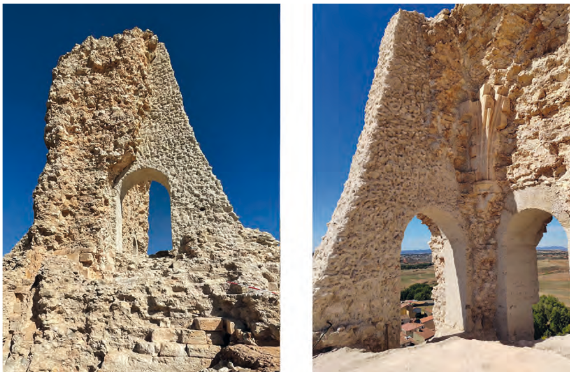
Figura 4. Refuerzo estructural del muro suroeste
