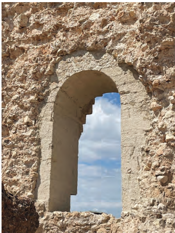
Figura 3. Refuerzo de los arcos desde el interior y exterior
