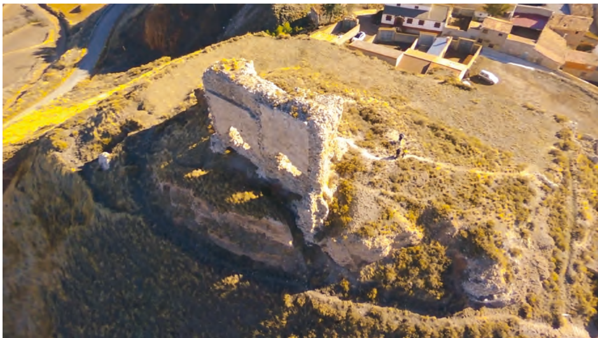
Figura 1. Vista cenital del estado previo a la intervención.
