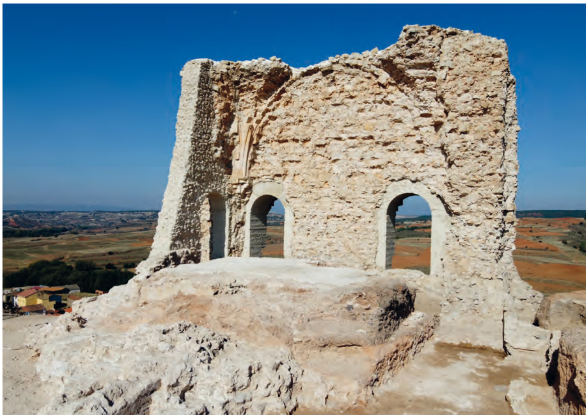
Figura 4. Vista aérea del Castillo desde el Este, durante la restauración y la excavación arqueológica.
