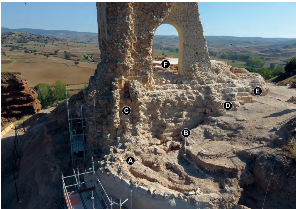
Figura 5. Vista aérea del Castillo desde el Sur, con la solera UE 23328 y sus canales revestidos de yeso (A) y los sucesivos pavimentos de H-3 y H-2 (B); tanto en el contrafuerte de la esquina Sur (C) como en el central del muro SW (D), se aprecia la existencia de una fase del Castillo I de la Mitra, forrada por otra del Castillo II; sillares escalonados en el muro SW del Castillo II (E); a través de un amplio vano, se aprecia el pavimento del interior de la Torre Celouquia (F).
