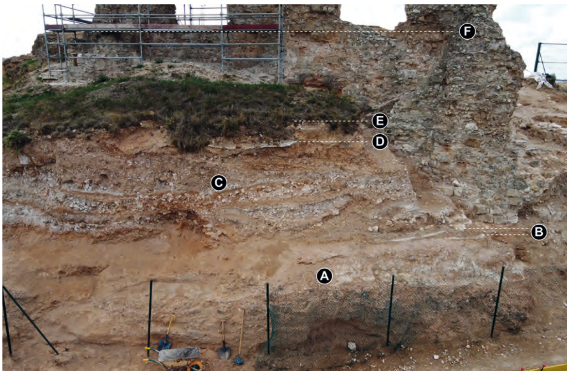
Figura 2. Exterior del flanco NW de la Torre Celozquia : restos del muro perimetral andalusí (A) y suelos asociados (B); rellenos generados en H-4, que quedaron sustentados por el muro perimetral (C); suelos asociados al reboste de H-3 (D y E); nivel aproximado de los miradores de H-3 (F).
