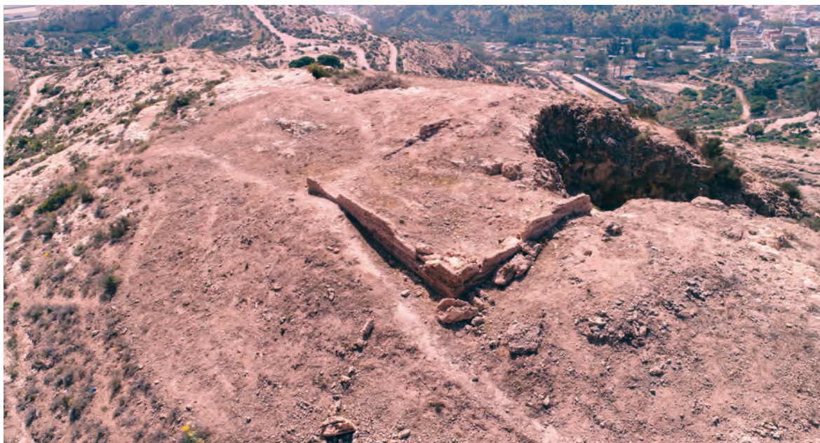
Figura 6. Vista de la torre A7 antes de la restauración (10-04-2023).
