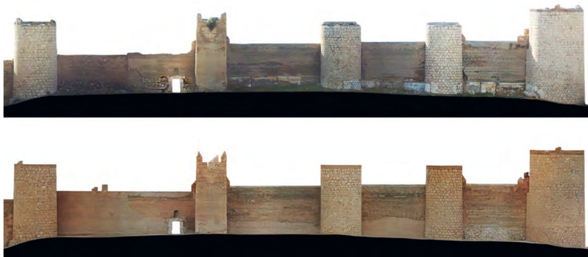
Figura 3. Ortofotografía general de la cara norte del tramo C1-C5 antes (arriba) y después (abajo) de la restauración.
