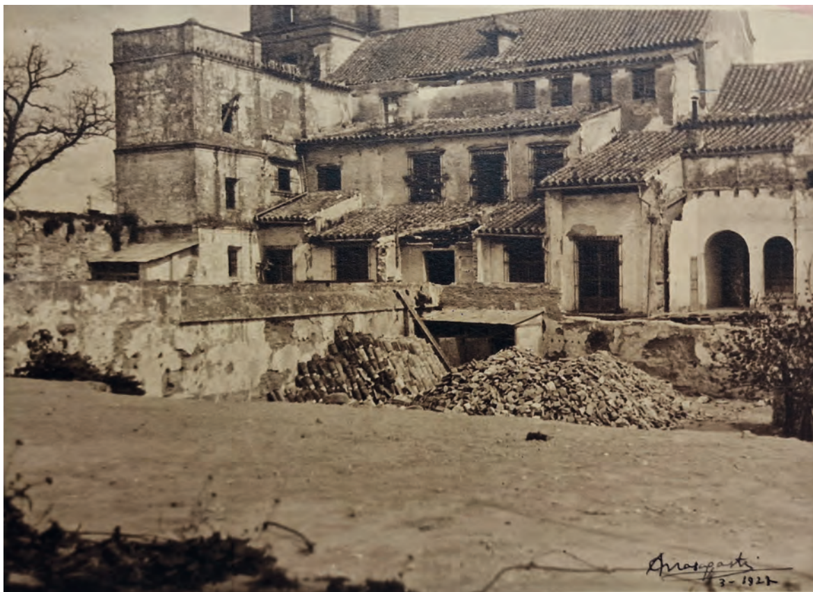
Figura 3. Foto del estado de los trabajos de restauración del Palacio Villavicencio según el proyecto de Teodoro Anasagasti en 1927. AMJF-AFDL, C.2-30, 719.
