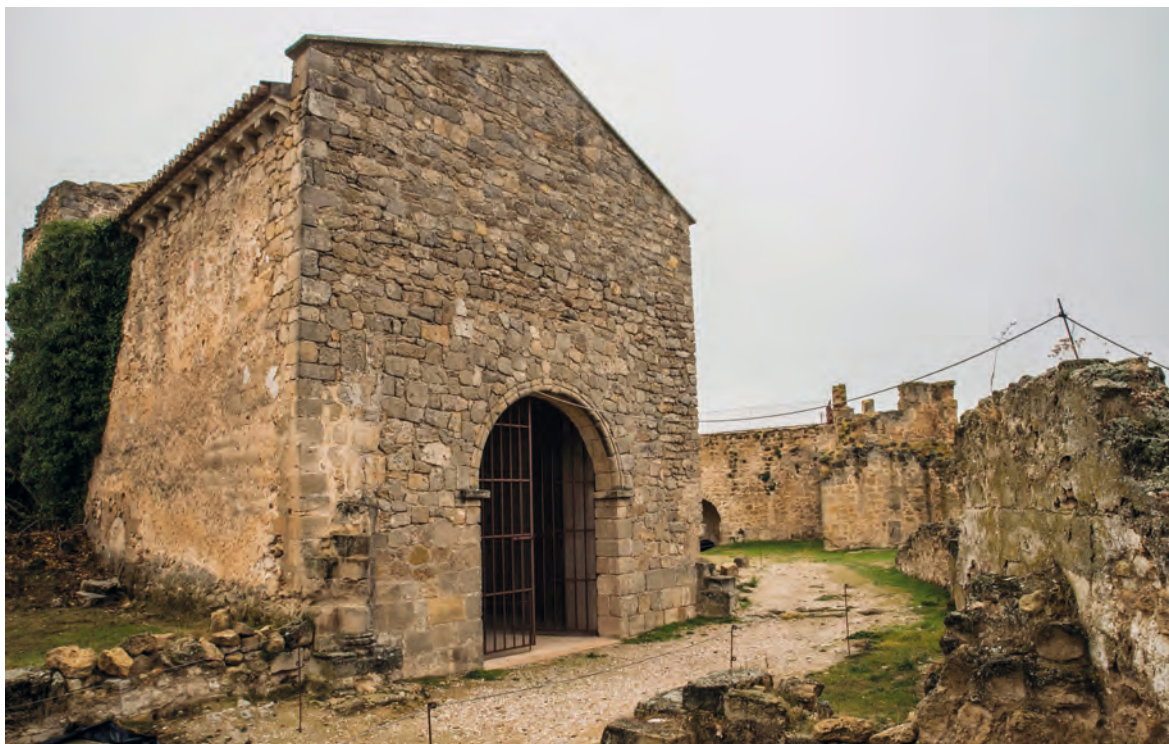
Figura 4. Fachada occidental del templo, con vestigios mínimos del nártex. Antigua iglesia prioral de San Benito, Zorita de los Canes (Guadalajara). Fotografía del autor.
