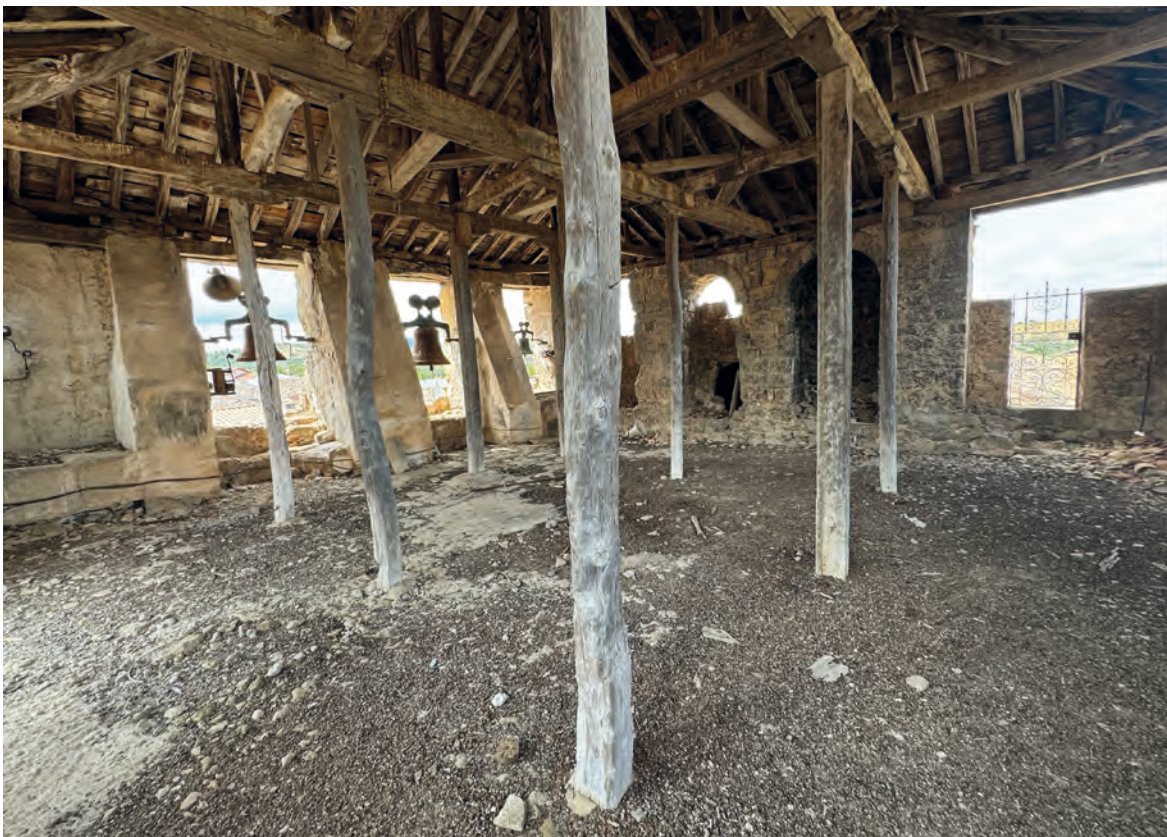
Figura 6. Cuerpo de campanas de la torre, con los restos de la espadaña medieval. Iglesia de Santo Domingo de Silos, Almonacid de Zorita (Guadalajara). Fotografía del autor.
