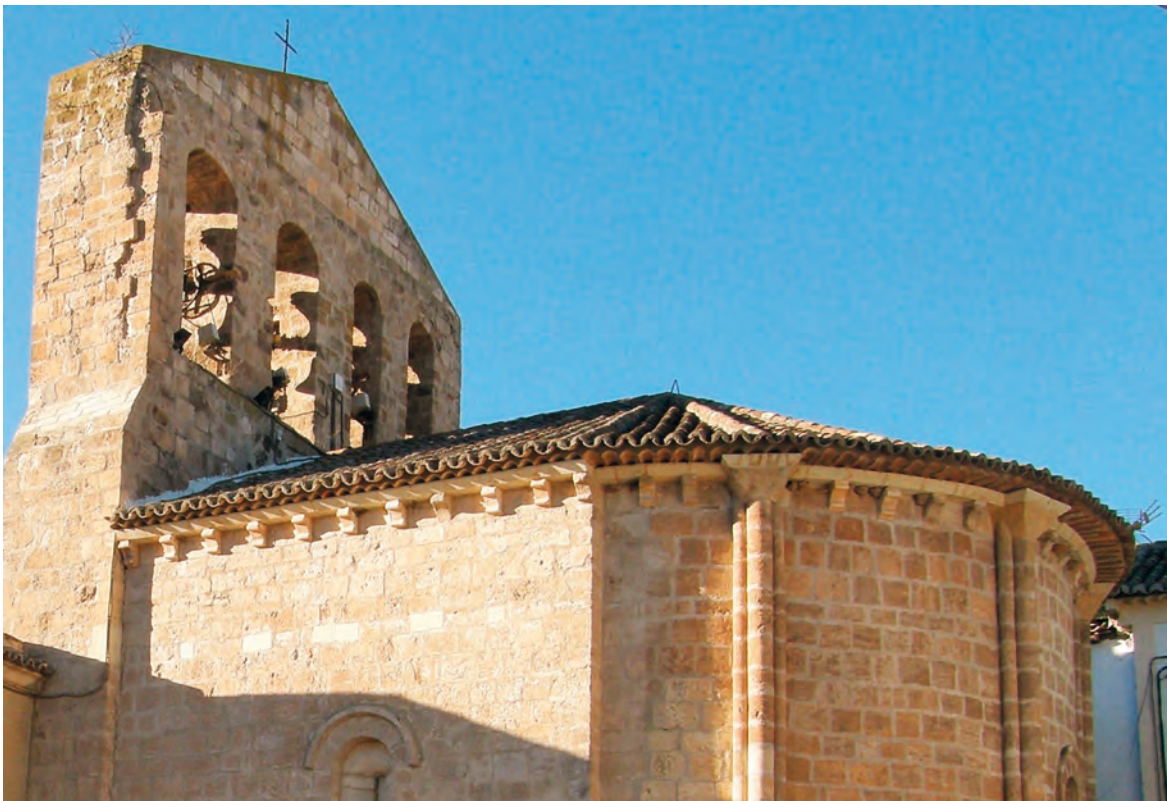
Figura 5. Detalle de la espadaña y el ábside en su estado actual. Iglesia de San Pedro Apóstol, Hontoba (Guadalajara). Fotografía del autor.
