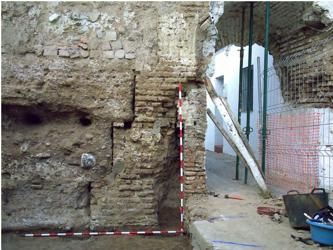
Figura 4. Contacto entre el paramento de la muralla y la puerta.
