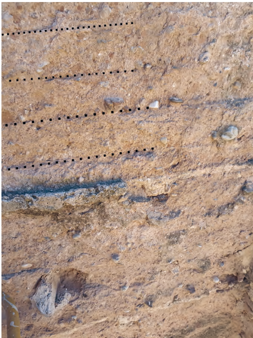
Figura 2. Huellas del pisón
