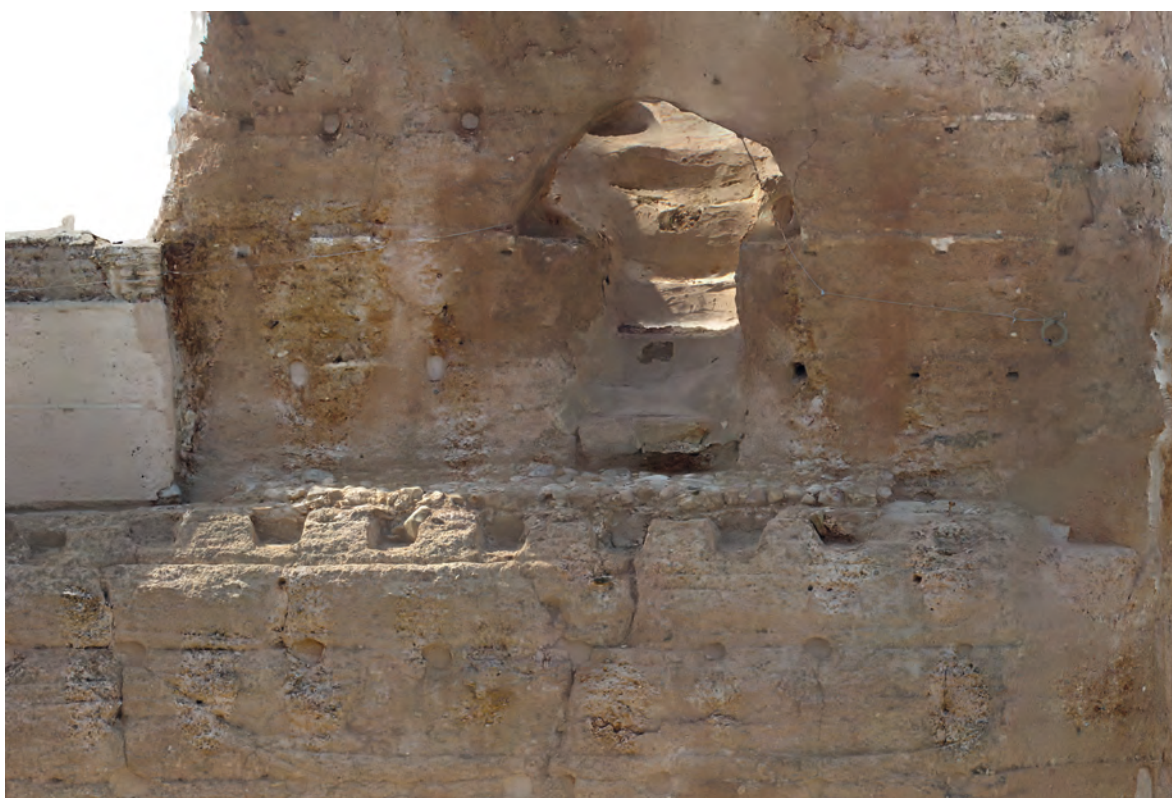
Figura 4. Huellas de las vigas pertenecientes al cadalso o balcón volado.
