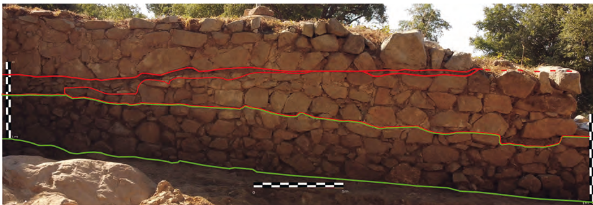
Figura 4. Detalle de la cara externa oeste del tramo norte de la muralla del recinto A.
