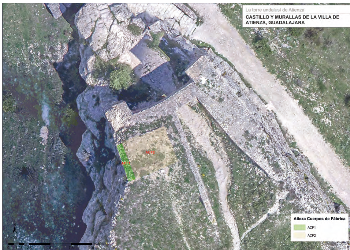
Figura 3 Planimetría SIG con la ortofotografía realizada para el plan director en donde se ha señalado la superposición de los dos cuerpos de fábrica que configuran la torre andalusí
