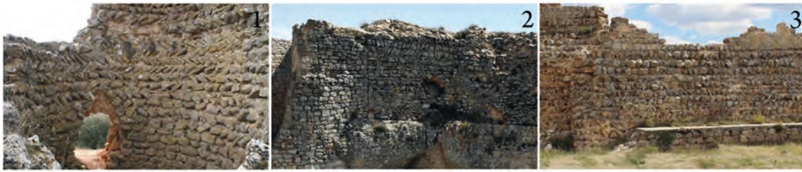
Figura 9. Comparativa de tipología aparejo murario en spicatum. 1. Torre de Membrillera, 2 Torre de Atienza, 3 Aparejo interior del lienzo surde la fortaleza de Gormaz
