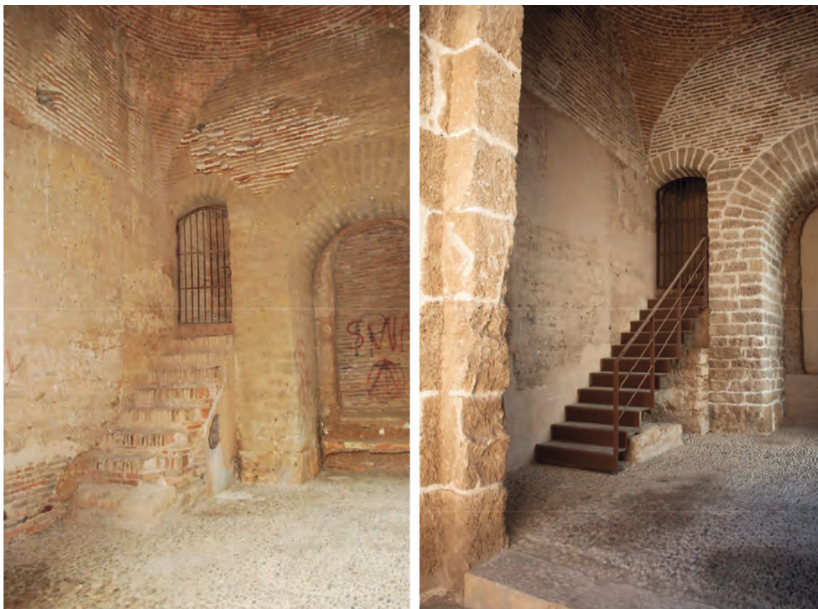
Figura 5. Estado inicial y final del interior de la puerta del Buey
