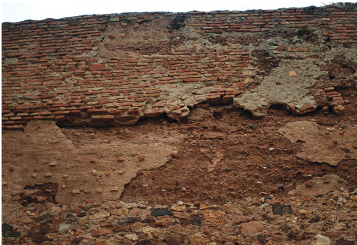
Figura 3. Detalle de recocado y forro de la coronación del lienzo de muralla junto a la puerta del Buey, atribuidos a D. Félix Hernández
