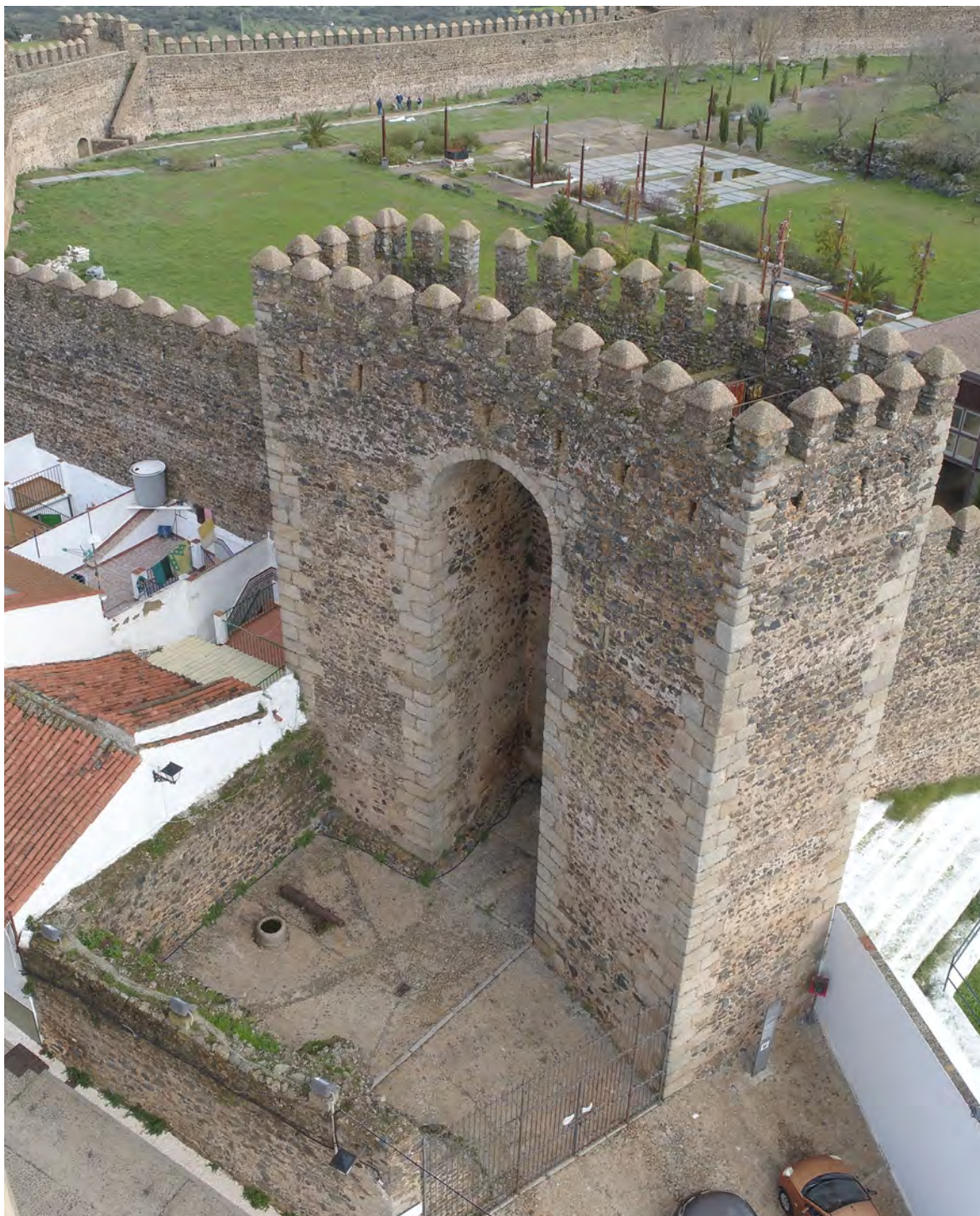
Figura 1. Imagen de la Puerta de San Miguel en la que se reconocen evidencias estratigráficas que han permitido documentar el proceso evolutivo de la fábrica.
