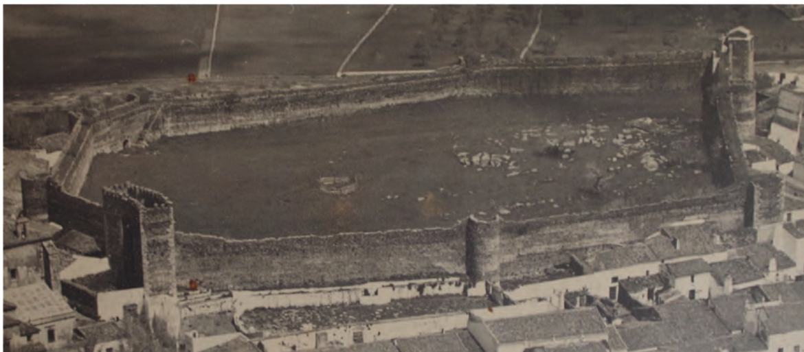
Figura 1. Estado del castillo con carácter previo a las obras de restauración iniciadas en los años 70 del pasado siglo. Fuente: Archivo Municipal de Cumbres Mayores.
