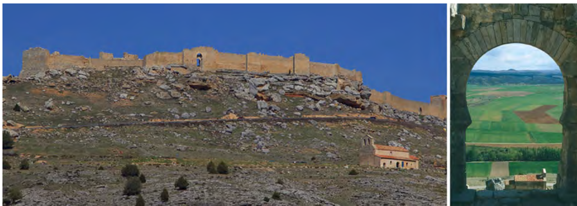
Figura 4. Dominio y control visual : fortaleza califal de Gormaz en la frontera del Duero (COBOS 2022)
