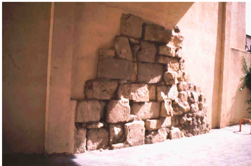
Figura 11.- Sección de la cerca vieja en la calle del Tostado de Salamanca
