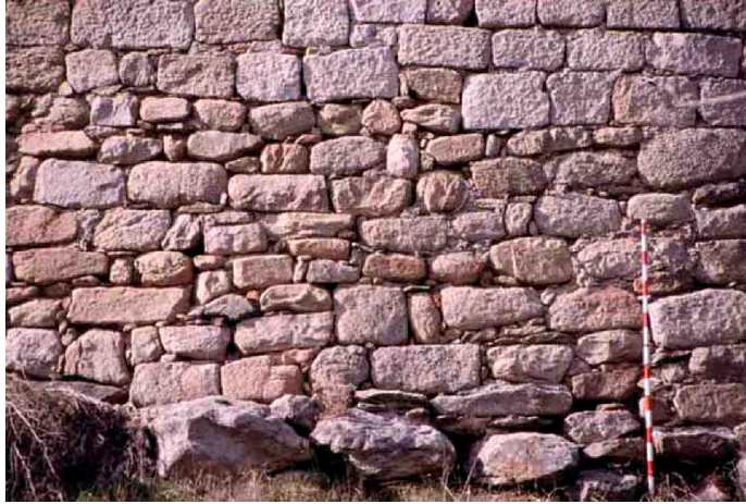
Figura 15.- Paramento en mampostería de grandes bloques sobre la muralla de Ledesma. Corresponde a la repoblación de Ramiro II.
