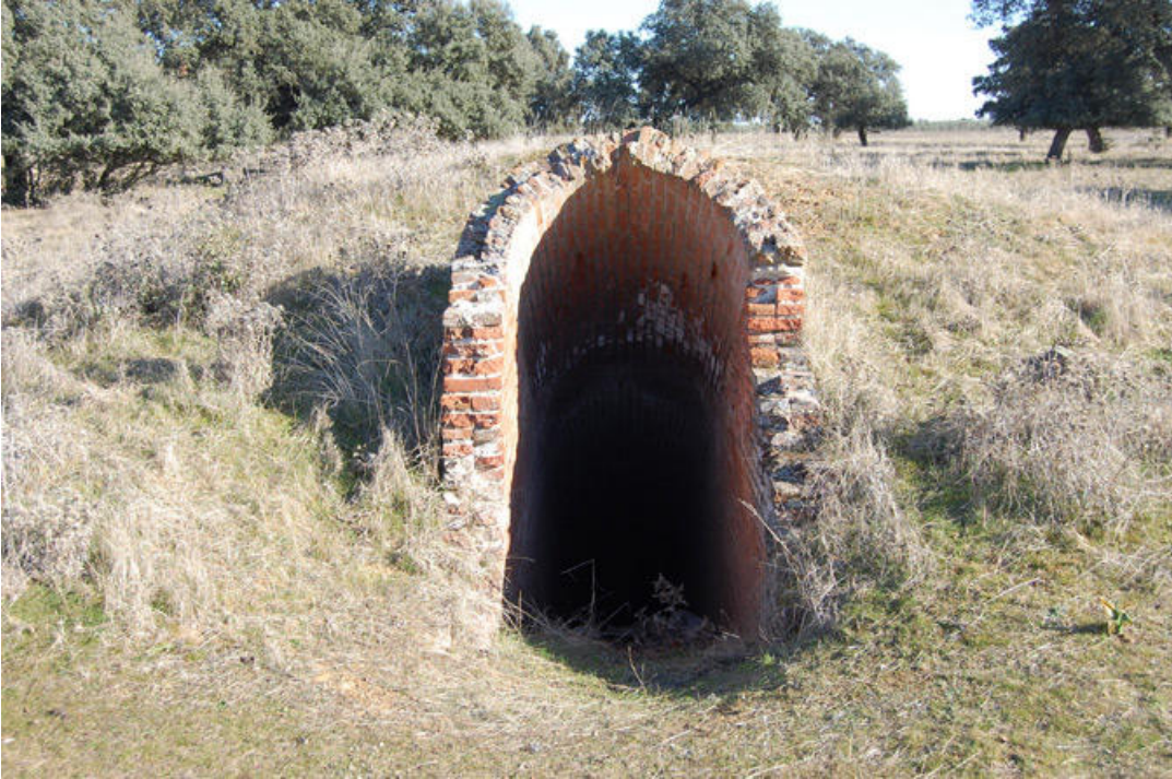
Una de las entradas al refugio antibombas del aeródromo de Benquerencia
