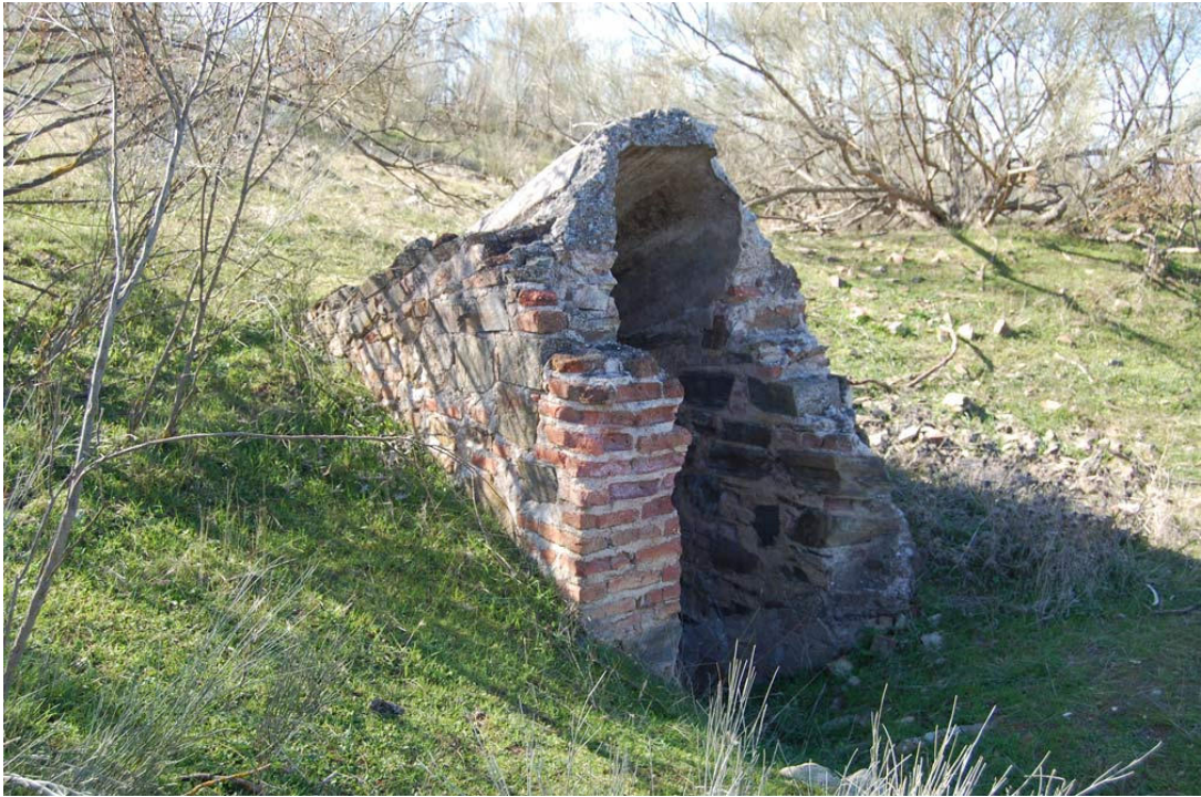
Boca de entrada al refugio situado junto a las trincheras en La Madrileña
