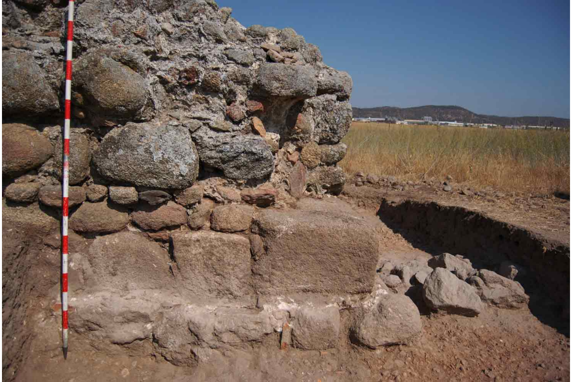
Detalle del sistema de cimiento del ángulo SE (Foto C. Pacheco)
