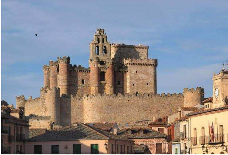
Vista general desde la plaza mayor
