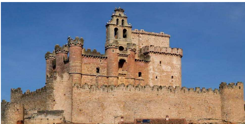
Vista de la fachada meridional del castillo
