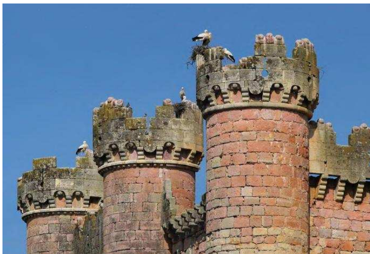
Detalle coronación cubos lado occidental
